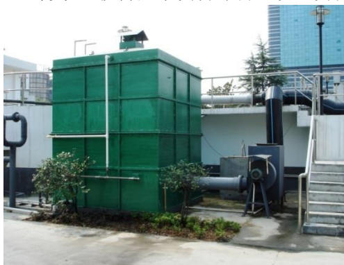
图 1 生物过滤除臭装置（4000m 3 /h，用于污水处理厂恶臭气体治理）
